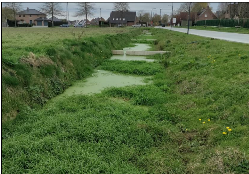
Figuur 89: Infiltratie in project Bergkapel
