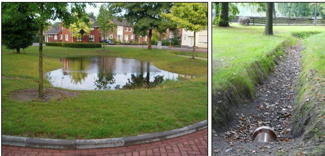
Figuur 71: Voorbeeld wadi en infiltratiegracht (Waterbewust bouwen, 2020)
