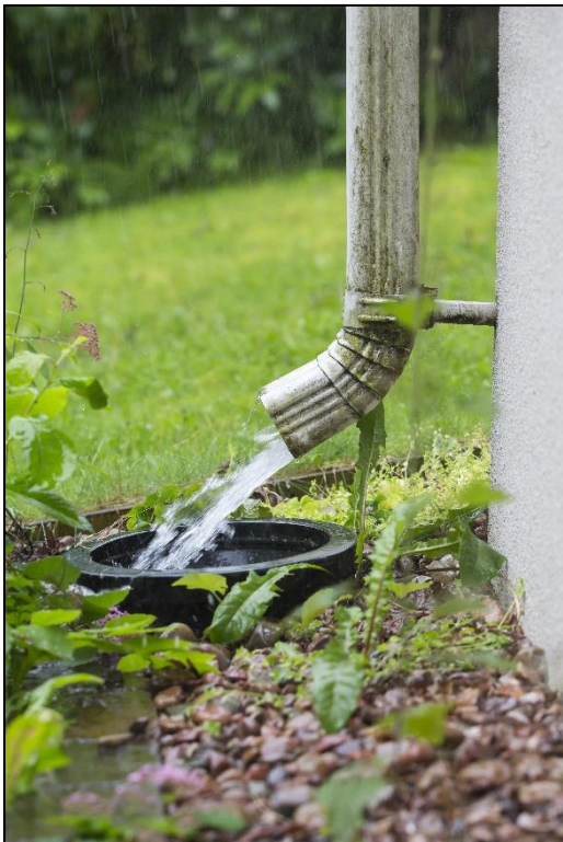
Figuur 67: Afkoppelen dakafvoer van het afvoerstelsel
