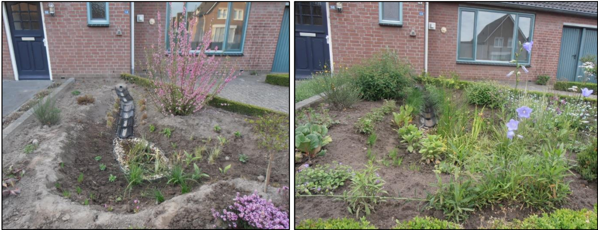
Figuur 65: Regenwater naar wadi in voortuin (links: aanleg wadi, rechts: wadi voltooid) (Van Eck, G., sd)
