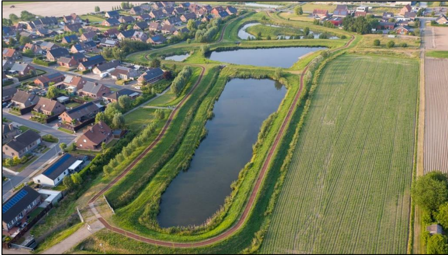
Figuur 76: Bufferbekken Pittem (Demey Infrabureau, 2020)
