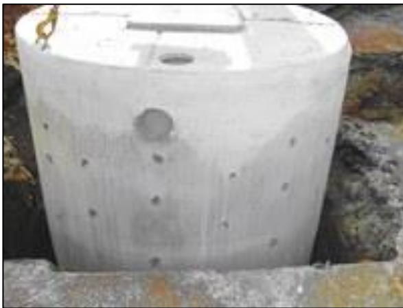
Figuur 93: Infiltratieput (VMM, Infiltratie, 2020)
