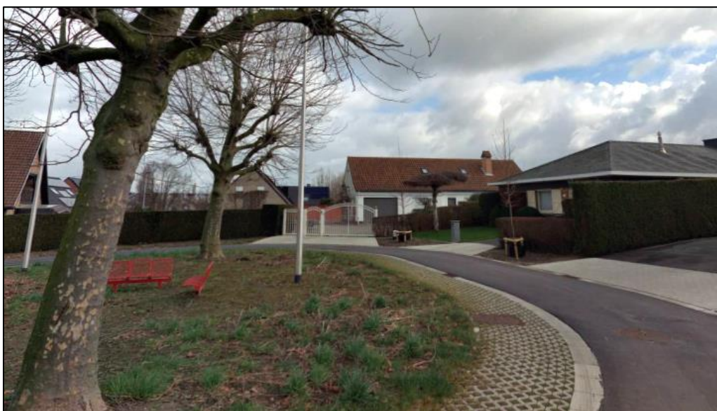
Figuur 70: Infiltratie mogelijk gemaakt door waterdoorlatende verharding - Wilgenlaan
