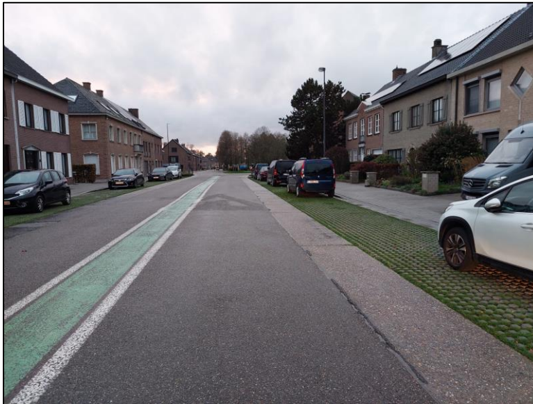
Figuur 86: Waterdoorlatende parkeerstrook Eupenlaan, Temse
