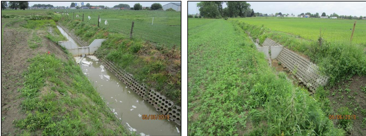
Figuur 95: Voorbeeld van een buffergracht in Ingelmunster
